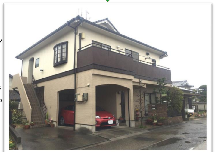
松山市 T様邸 新築のような外観に生まれ変わり、劣化部分を補修し 新たな塗料を塗装することで、風雨や太陽光線から 大切な家を守ります。
